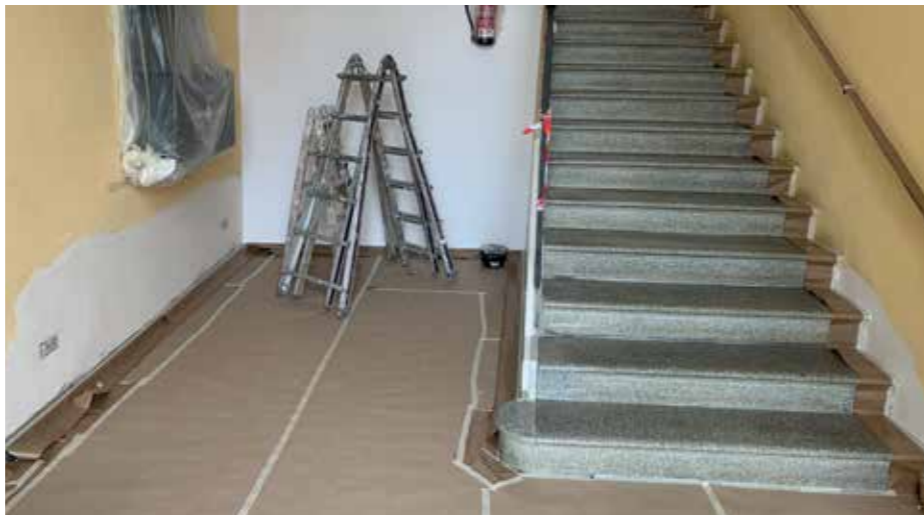
Les obres de la nova plataforma elevadora a l'Ajuntament.
